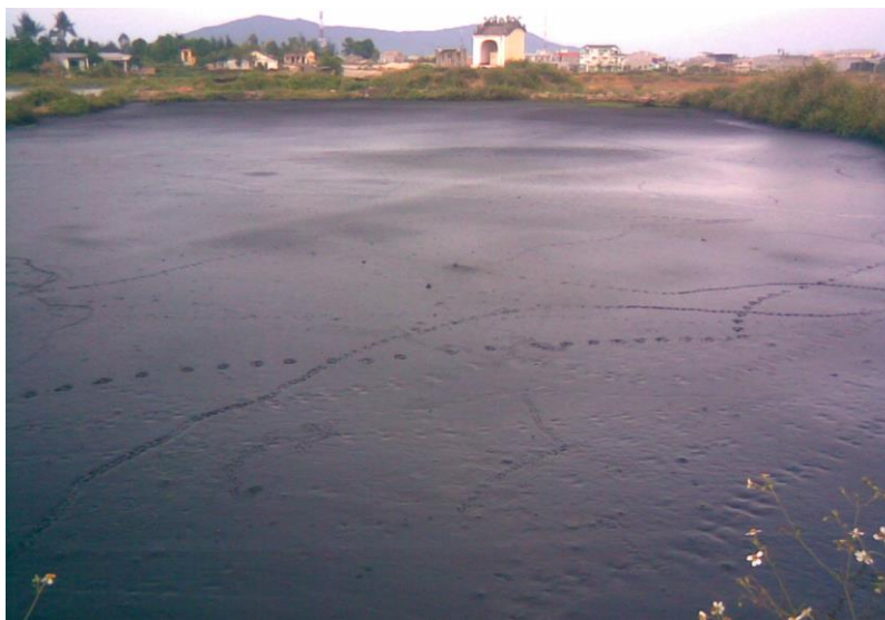
Hình 3.1. Than bùn đã được hút từ lòng hồ lên bãi chứa
